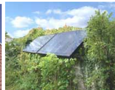
S'il s'avère difficile d'implanter les capteurs en toiture ou en façade (orientation défavorable, surface réduite, intérêt architectural à préserver), ils peuvent être isolés de la construction et posés au sol, ou adossés à un mur.
