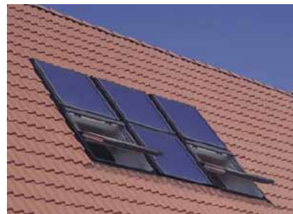
La création de fenêtres de toit peut aussi être l'occasion d'installer des capteurs et de les associer dans une composition d'ensemble.
