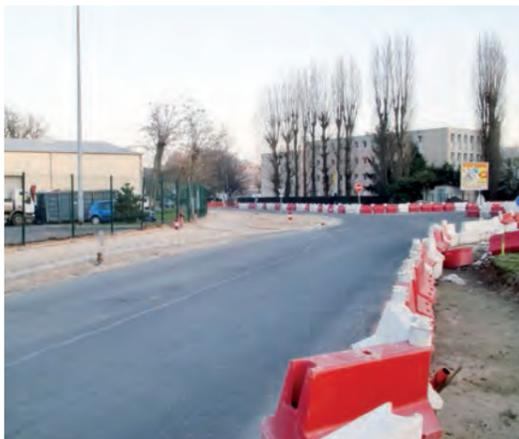
Les aménagements de circulation empruntés par les automobilistes permettent de voir sans problème (aux heures de pointe en particulier) la bonne avancée des travaux. En ce début de printemps, les trottoirs (côté Accacias) vont recevoir leurs enrobés et le carrefour-giratoire voir son aménagement progresser (rabotage de la chaussée). Enfin, dans le même temps, pas moins de 17 mâts d'éclairage doivent également commencer à être installés.
